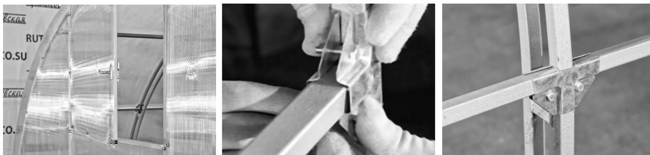
Форточка устанавливается в верхнюю часть двери. Форточка крепится сбоку на две петли при помощи саморезов 3,9\*19. Ручка и завертка устанавливаются после монтажа поликарбоната, но примеряются во время монтажа форточки для замера нормального закрывания язычка завертки.
