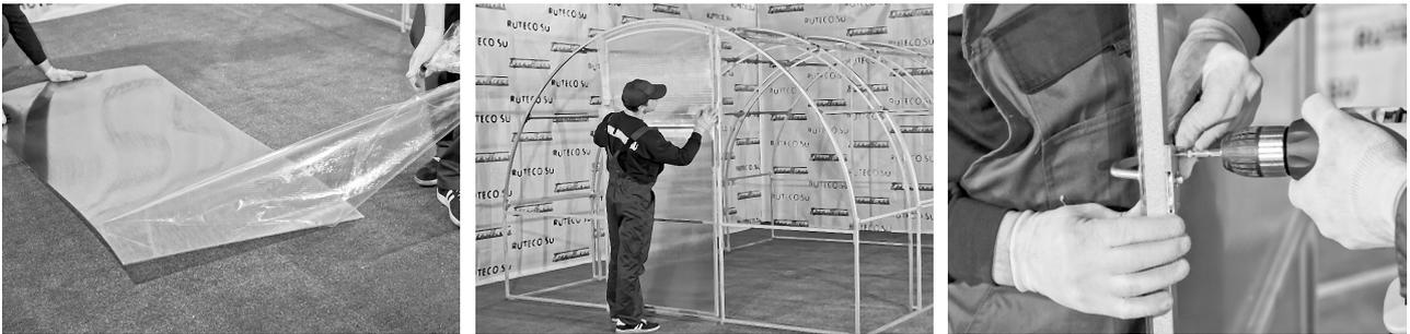
Поликарбонат в верхней части двери крепится только к каркасу форточкы, после чего прорезается по зазору между каркасом форточкы и перемычкой двери.
