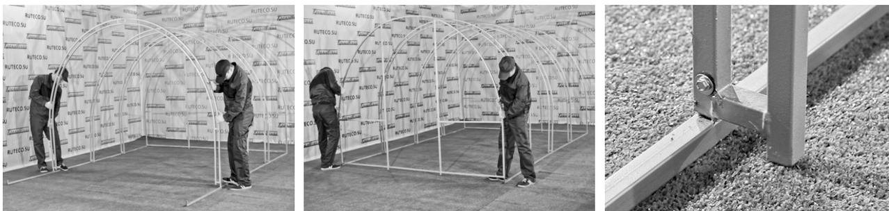
Далее установите перемычки (стяжки) с помощью спайдерных пластин стягивающихся болтами и гайками М6. Центральная перемычка монтируется в верхней центральной части дуги (в «коньке»). Боковые могут монтироваться как в 60см от земли, так и выше (1-1,7м от земли). Двойные спайдерные пластины (спайдеры) на дугах устанавливаются средним ручьем вниз. На торцах - средним ручьем в сторону. Спайдеры, при монтаже на дуге, должны опираться на междугловые соединения.
