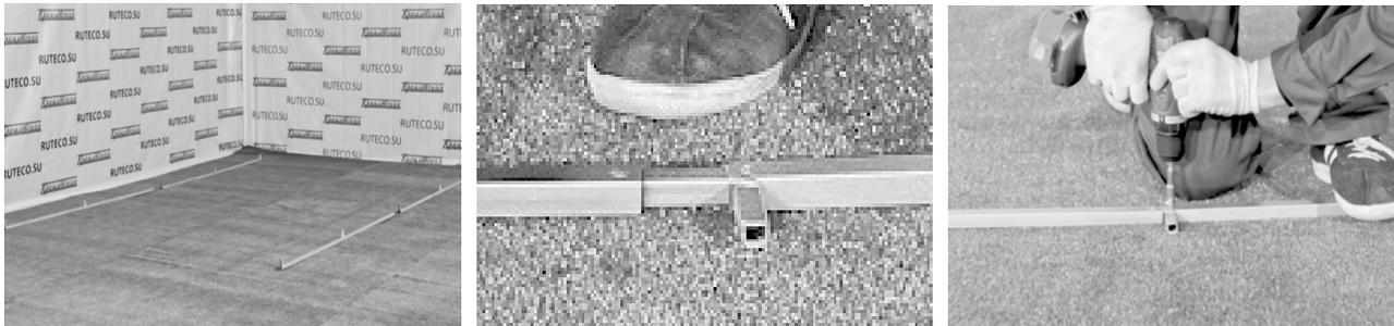
Затем необходимо собрать торцы и дуги. Все части соединяются при помощи надежно сваренной профильной трубы 15\*15 по принципу «папа-мама» и крепятся кровельными саморезами 5,5\*19. После соединения дуга приобретает дополнительную жесткость за счет эффекта «труба в трубе».
